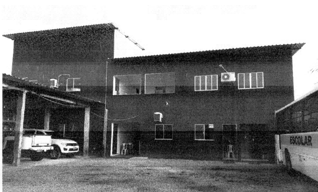
FOTO DA GARAGEM – ÁREA INTERNA DO MURO
